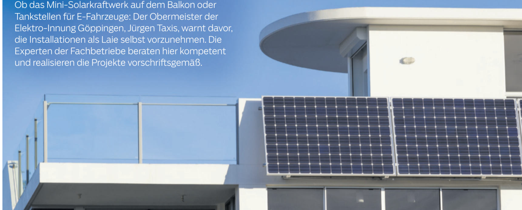
Auch den Anschluss von kleinen Photovoltaikanlagen muss ein Fachmann machen, der dabei die gesamte Hausinstallation im Blick hat.
