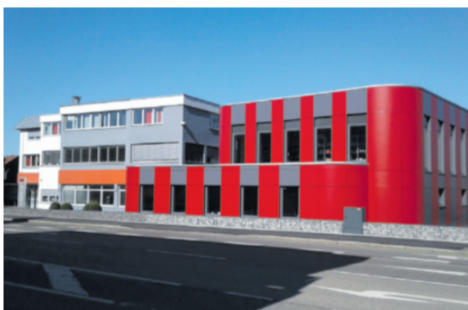
Erweiterung: Der neue Anbau rechts beherbergt das Aus- und Weiterbildungszentrum mit Lehrwerkstatt für die perfekte Förderung des Nachwuchses. Foto: Architektur Keller
