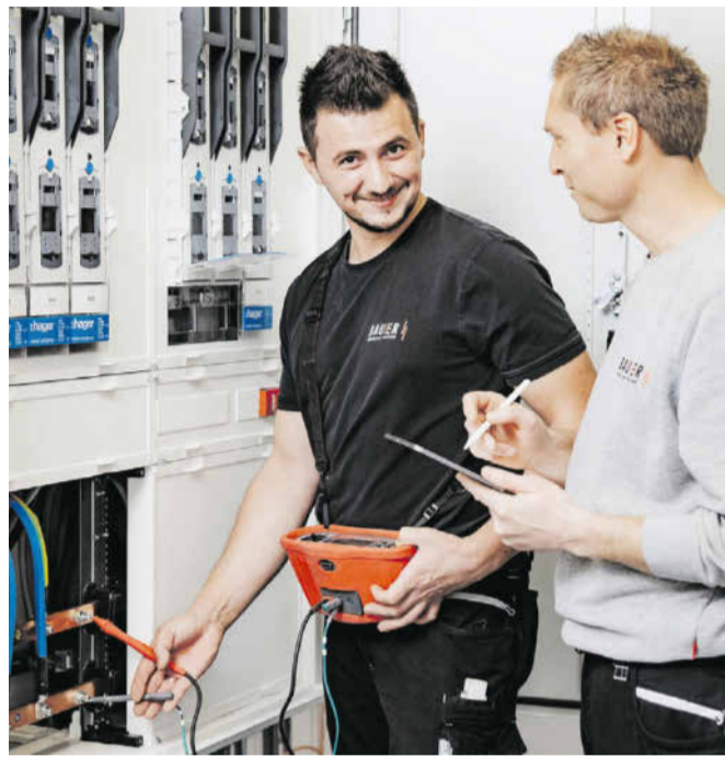
Regelmäßige Schulungen der Mitarbeiter sind dem Unternehmen wichtig. Foto: Bauer Elektroanlagen
