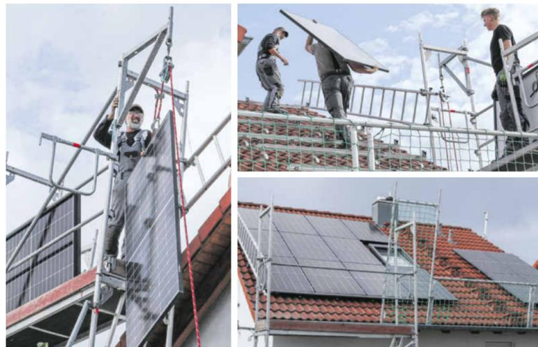
Mit dem Seilzug werden die Module nach oben gebracht und anschließend platziert. Auf der gegenüberliegenden Seite des Dachs sind die Module bereits fertig montiert. Gerüste und Netze sorgen für die Absturzsicherung.
